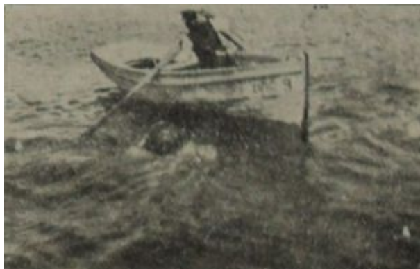
Водолазъ, който долу намества камънитъ, за да бждат поставени грамаднитъ блокове на преградния вълноломъ.
